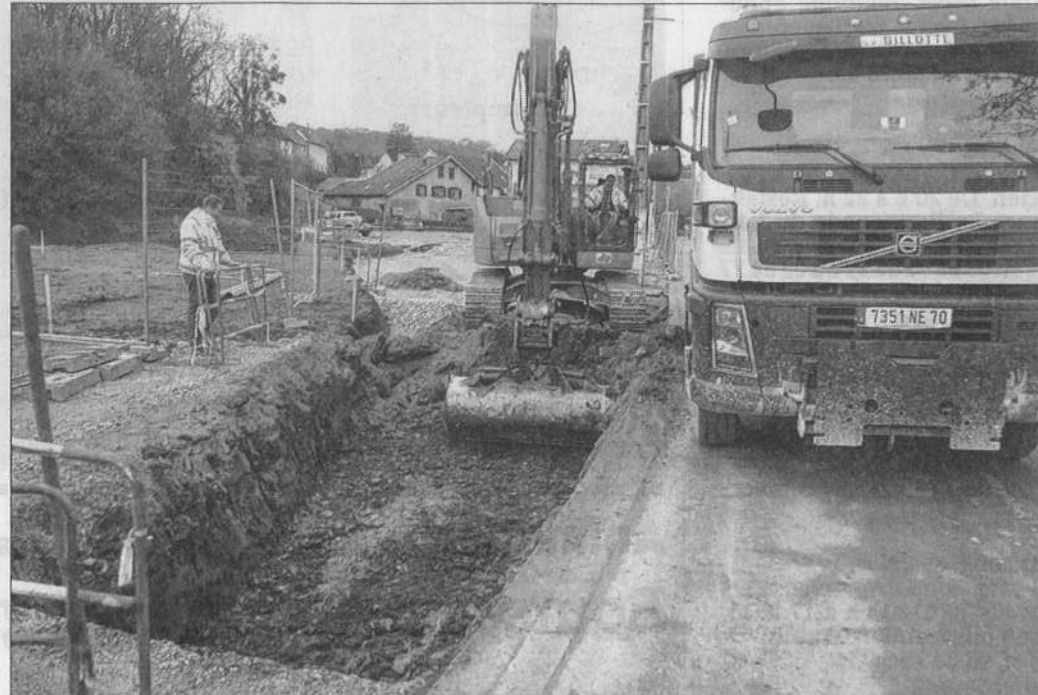
■ Le décalassement de la nouvelle départementale par l'entreprise Billotte de Granges-le-Bourg.
